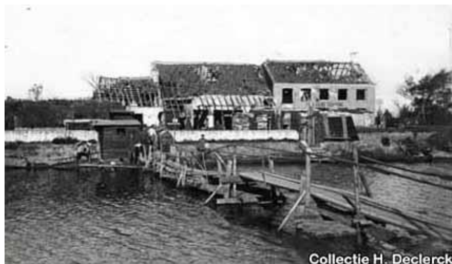
Loopbrug over de IJzer ter hoogte van het gehucht Tervate (17)
